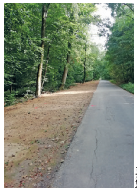
Planierter Waldrand in Kelkheim
